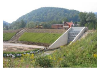
C. Retention basin Weinitzen 2 Höfbach. https://www.graz.at/cms/dokumente/10278073_8028812/dccb_e8b0/Fotodokumentation%20RHB%20Weinitzen%202.pdf
