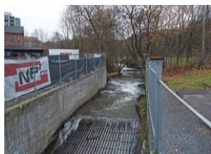
A. Culvert of Alna at Kvaernerfossene. https://www.skiforeningen.no/mar/ka/bilder/?poi_id=1912
