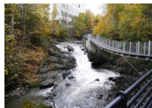
C. Suspension bridge along Alna, Svartdalen. https://no.wikipedia.org/wiki/Svartdalen#/media/Fil:Alna.jpg
